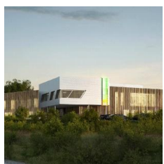
@photos : Construction du siège administratif du SDEM50 – Archipole – Thomas Poirier
